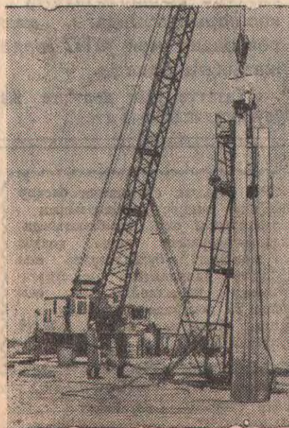
СУРЕТТЕ: (солдан оңға қарай) 1. Сталинград су ағын жерге шпунт қағу. 2. Куйбышев су электр станциясы
