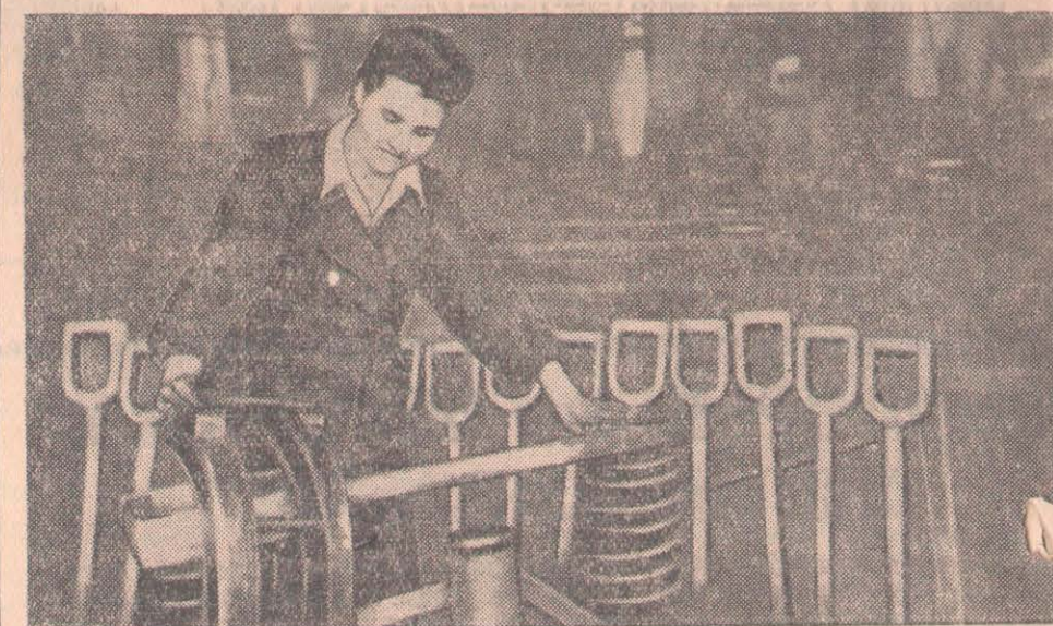
Петропавл паровоз депосында өнім сапасын бақылаушы болып істейтін Мария Смольянова өз жұмысында бірде-бір ақау жіберіп көрген емес. СУРЕТТЕ: Мария Смольянова тендордағы аспалы ресордың өнім сапасын тексеріп тұр. Суретті түсірген А. Розенштейн.
