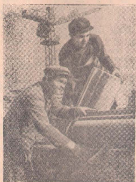
Өскемендегі металлургияшылар поселкесінде 56 пәтерлі тұрғын үй құрылысында алғаш рет үйді темірбетонды тақталармен қаптау қолданылды. СУРЕТТЕ: тас қалаушы Я. Колесников (сол жақта) пен бригадир В. Мусорин темірбетонды қаптағыш тақталарды орнатып тұр. (ҚазТАГ-тың фотохроникасы).
