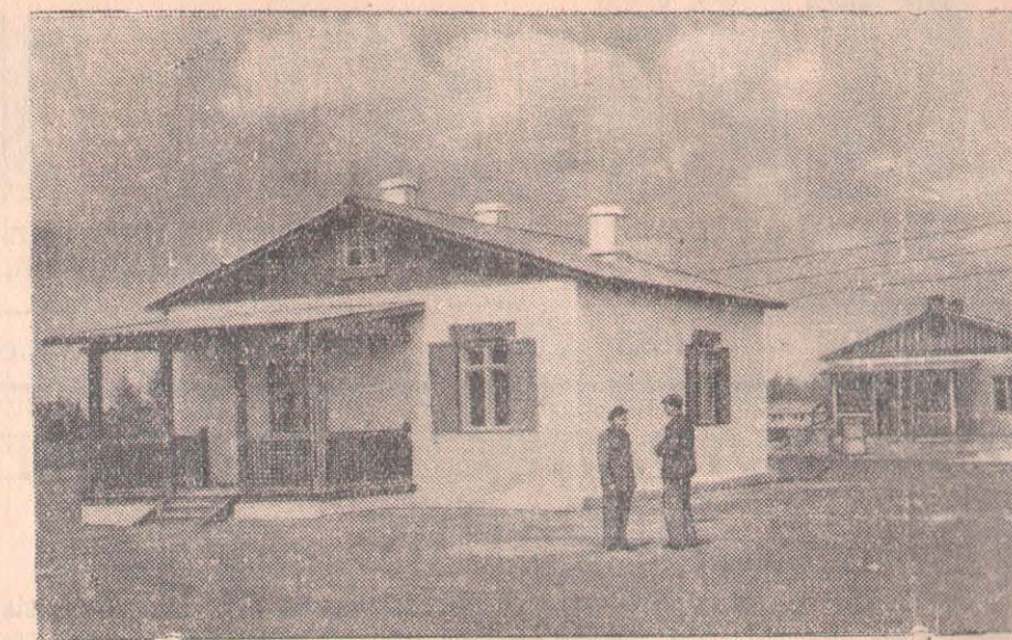
Преснов совхозында жұмысшылар мен қызметшілер үшін жеке тұрғын үйлер салу жұмыстары қызу жүргізілуде. Кәзірдің өзінде орталық усадьбада үй салында.
