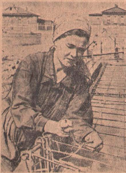
На сборке арматур для крупнопанельного строительства
