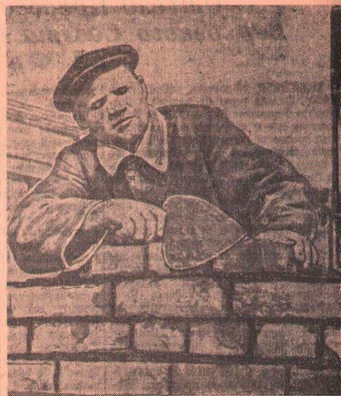
За плечами Андрея Семеновича Овередного, каменщика 6 разряда, 10-летний стаж. Сейчас он трудится на 1-м стройучастке завода прокатного оборудования и ежедневно перевыполняет сменные задания в полтора—два раза.
