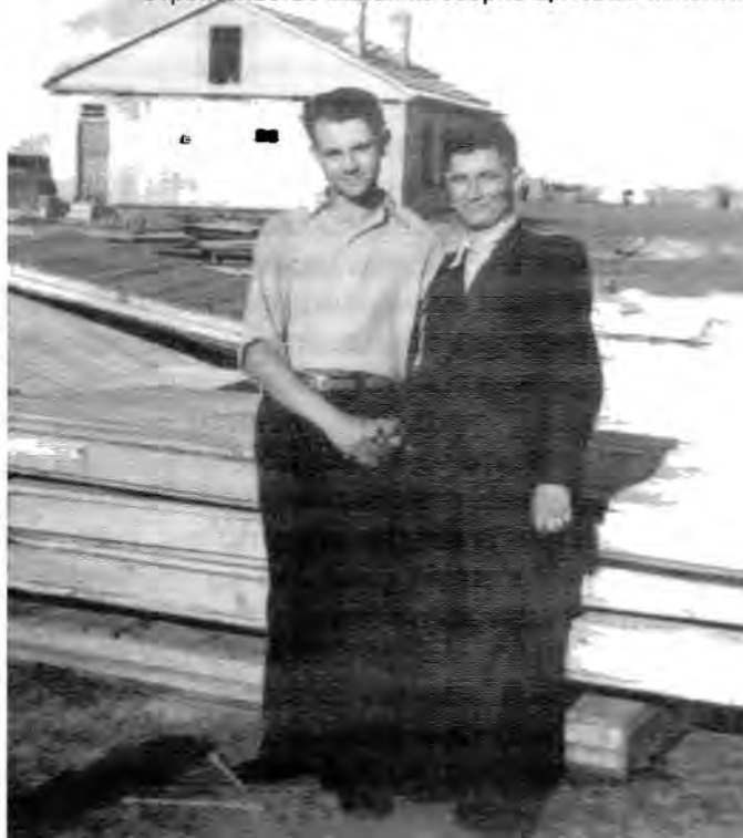
Строительство жилья из сборно-щитовых панелей
