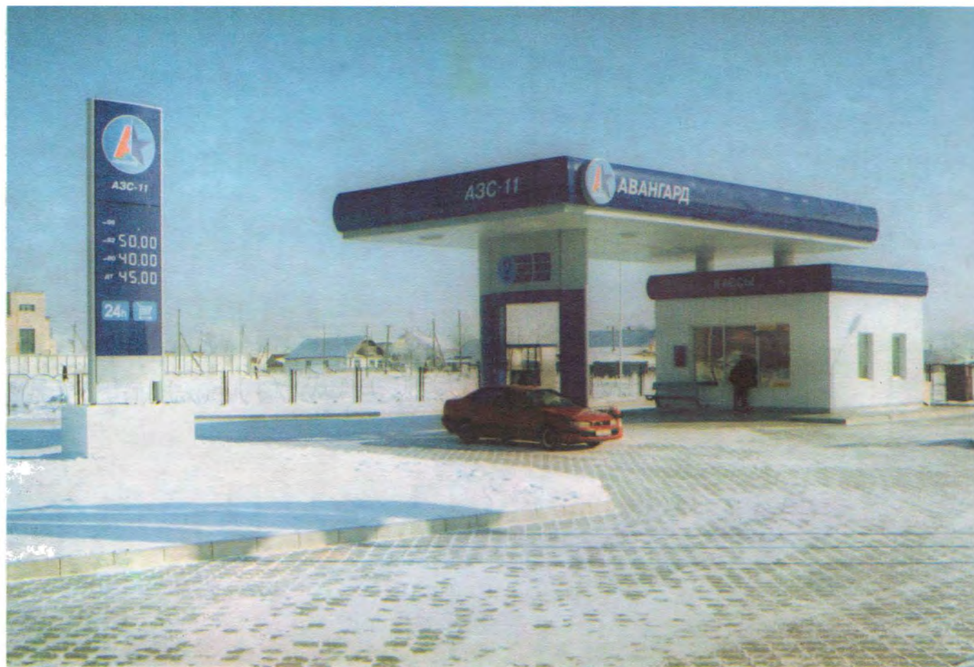
Автозаправочная станция „Авангард“
