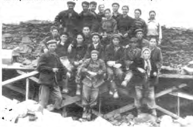
На строительстве складов Пескинского элеватора
