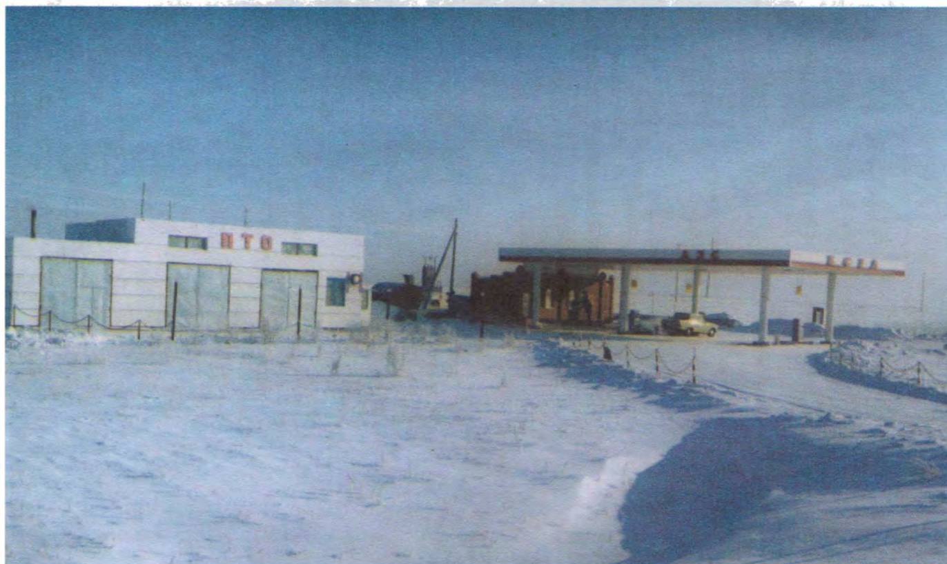
Автозаправочная станция „Еска“, пункт технического обслуживания
