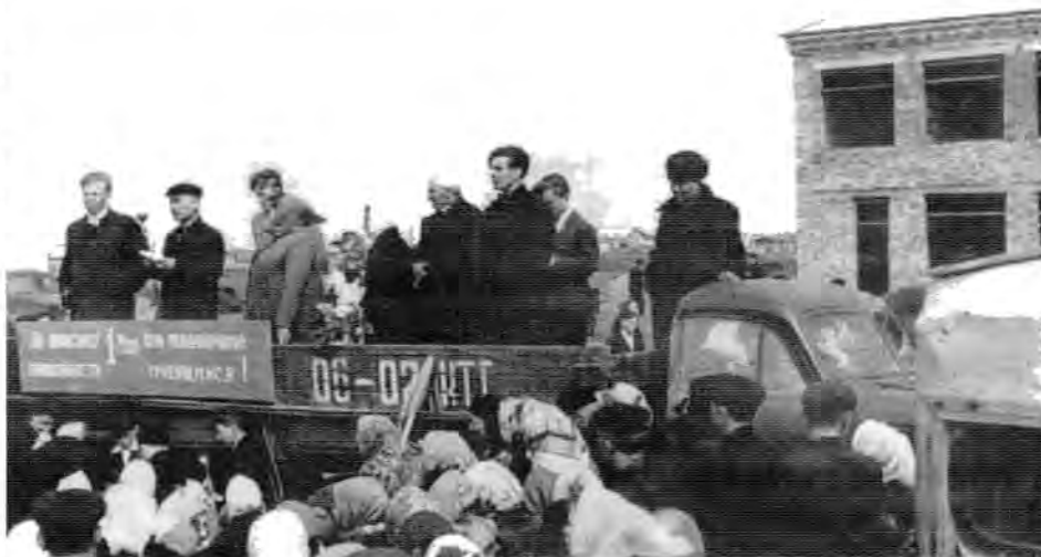
Строительство средней нежинской школы.
