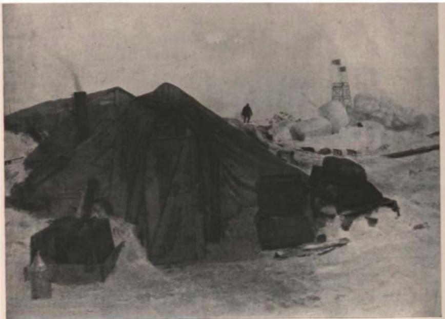
Палатка научных работников была хорошо оборудована. Ее натянули на деревянный каркас. Она имела два окна из отмытых фотопластинок. Палатка отапливалась при помощи устройства из железной бочки печи.
