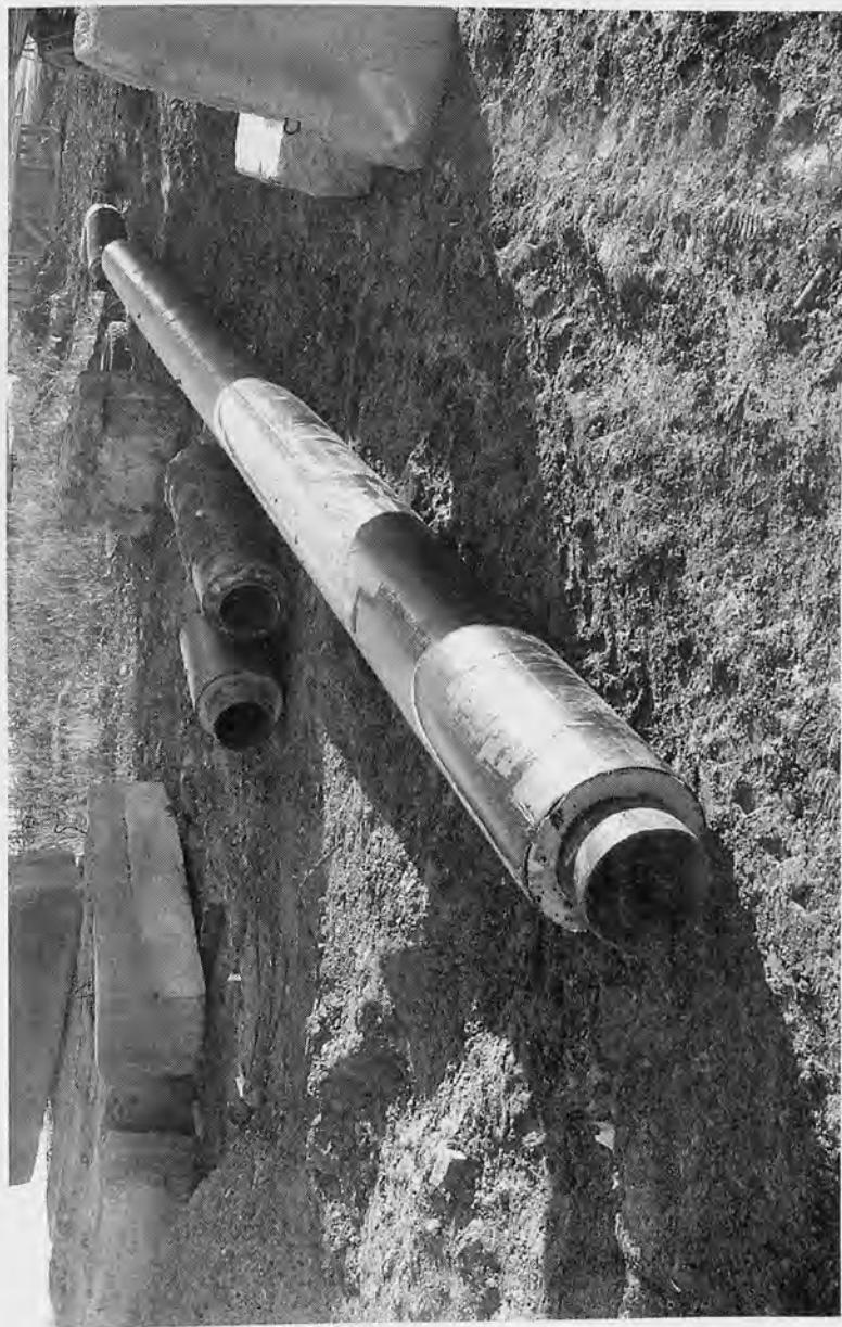
Предварительно изготовленная в пенополиуретановой изоляции труба в полихлорвиниловой оболочке. Новая технология. 2004 г.
