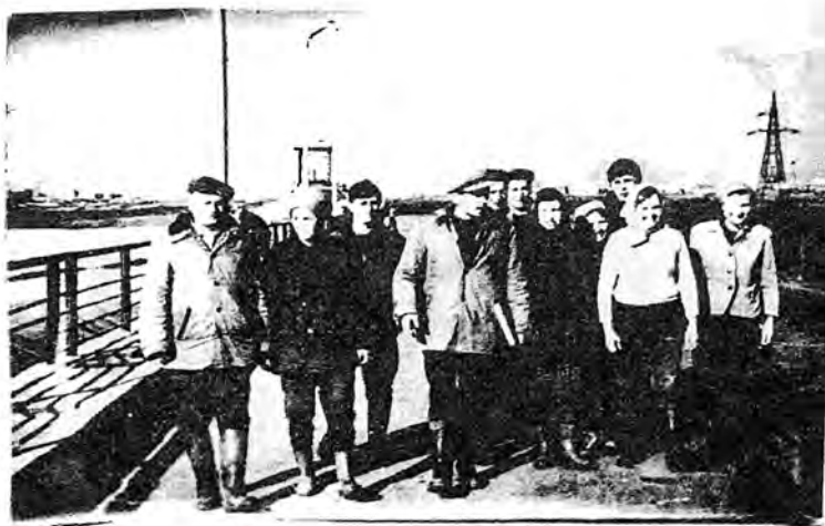
Они завершили работу по сооружению Сергеевской плотины. На переднем плане - прораб Кореньюгин В.В.
